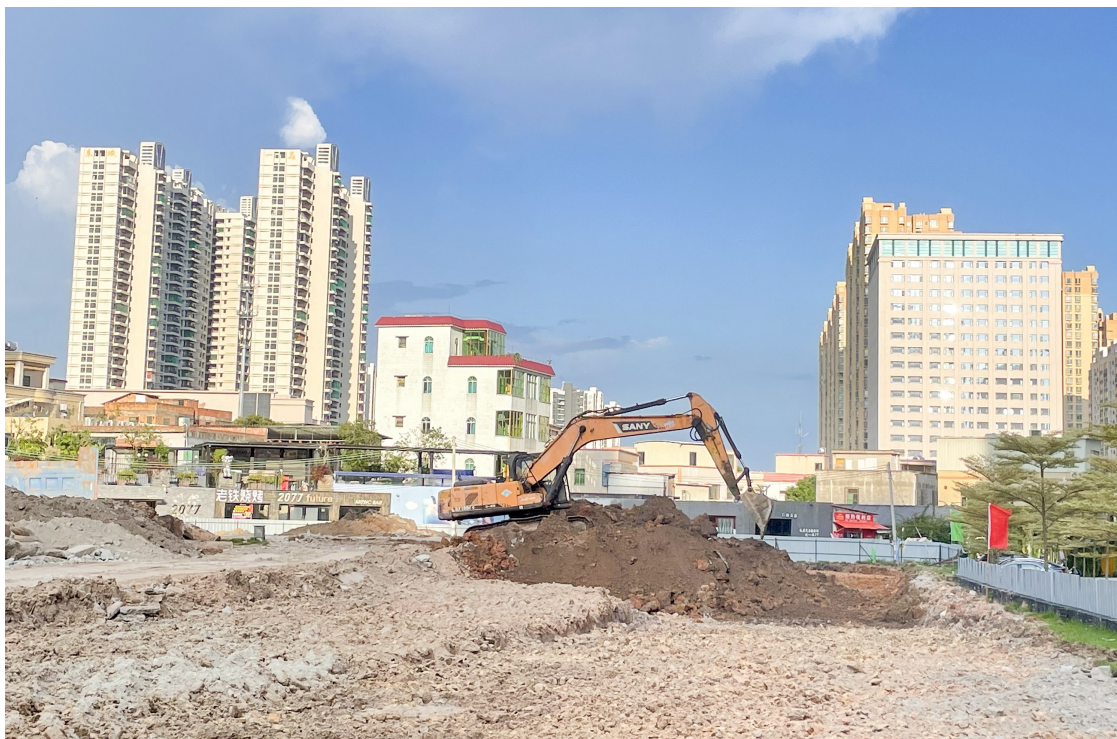
9月20日,记者在市区官山六路项目施工现场看到,上宾体育公园的运动设施已经全部拆除,施工人员正加紧进行路基工程施工,争取工程早日完工。
