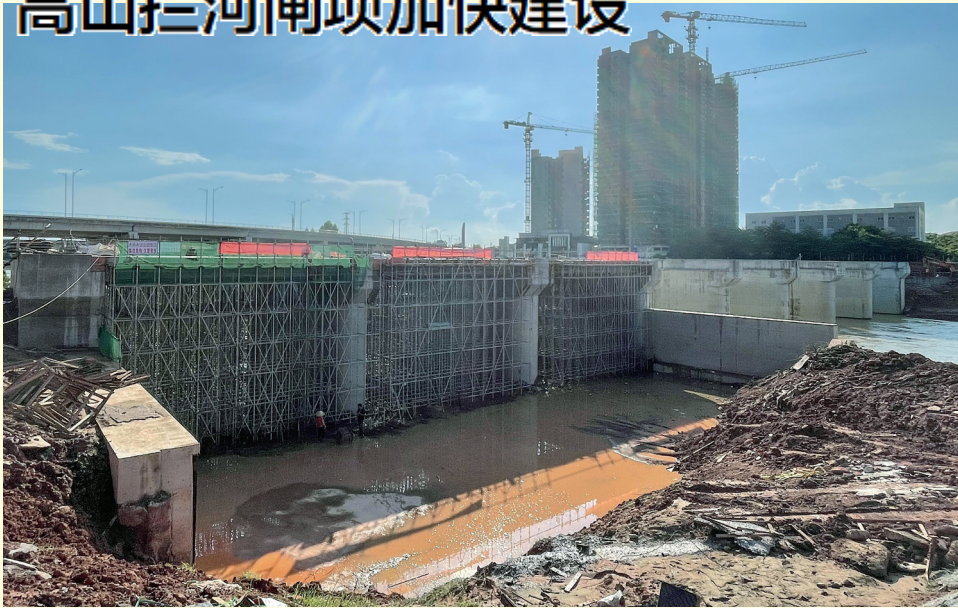
9月21日,在市区的高山拦河闸坝项目工程施工现场,施工人员正在加紧浇筑闸坝桥墩,争取工程在年底完工。 茂名日报社全媒体记者李颜东 摄
