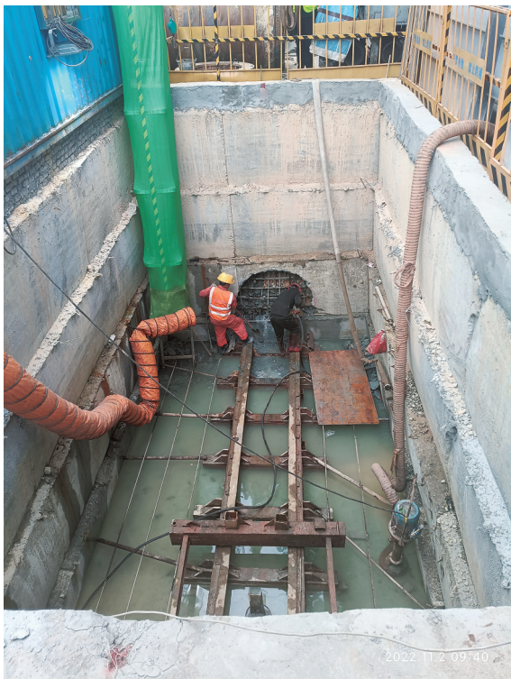
市小东江流域城镇生活污水管网完善工程施工现场。茂健 摄
