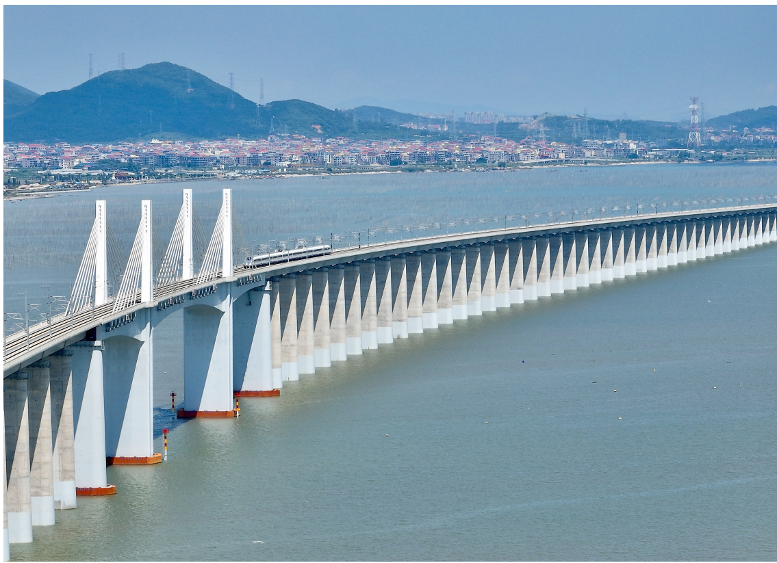
福厦高铁湄洲湾跨海大桥(9月19日摄,无人机照片)。 新华社记者 林善传 摄
