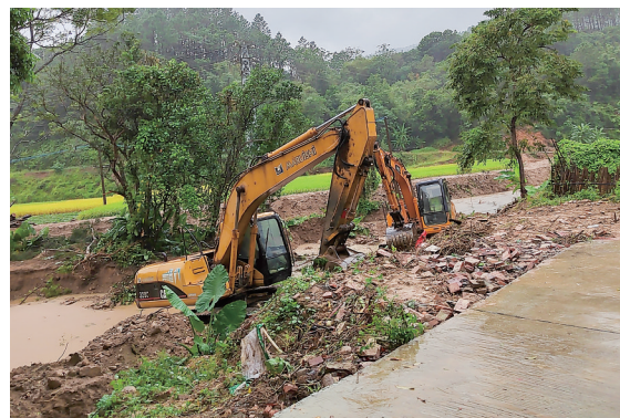
钩机已在河堤边作业。 茂名晚报记者 李光耀摄
