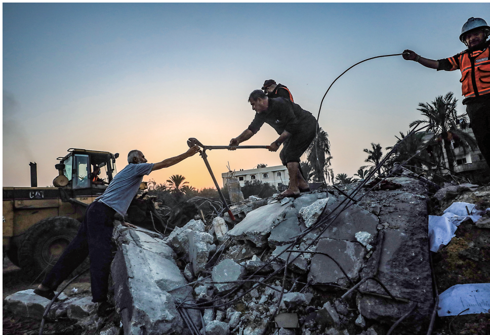
►10月23日,在加沙地带南部城市汗尤尼斯,人们在遭以色列袭击后的建筑废墟上救援。新华社发(亚西尔·库迪摄)
