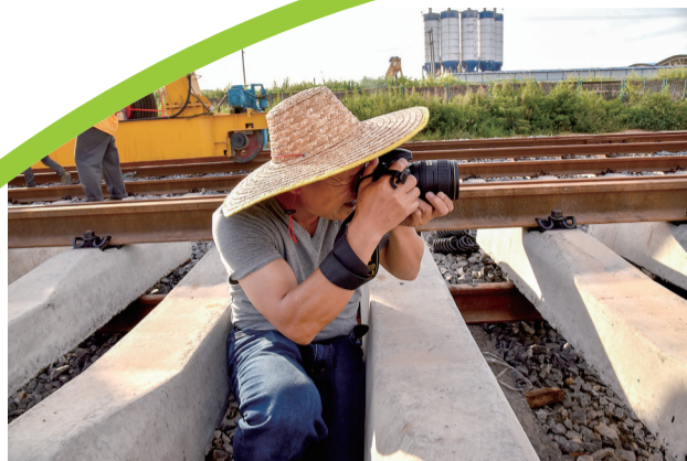
深入工地采访铁路建设。茂名日报社全媒体记者黄信涛 摄
