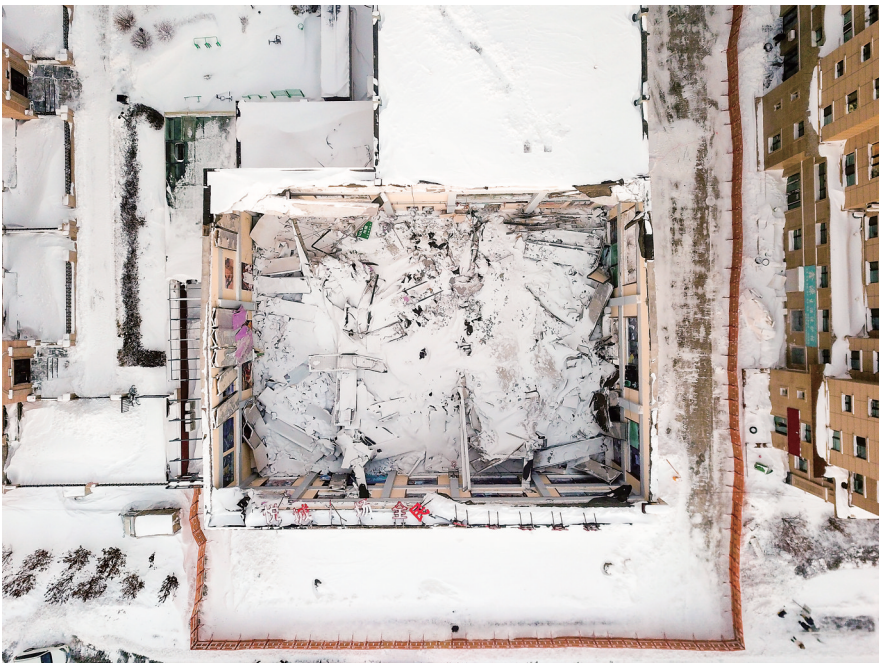
这是11月7日拍摄的发生屋顶坍塌事故的黑龙江省桦南县悦城体育俱乐部(无人机照片)。
