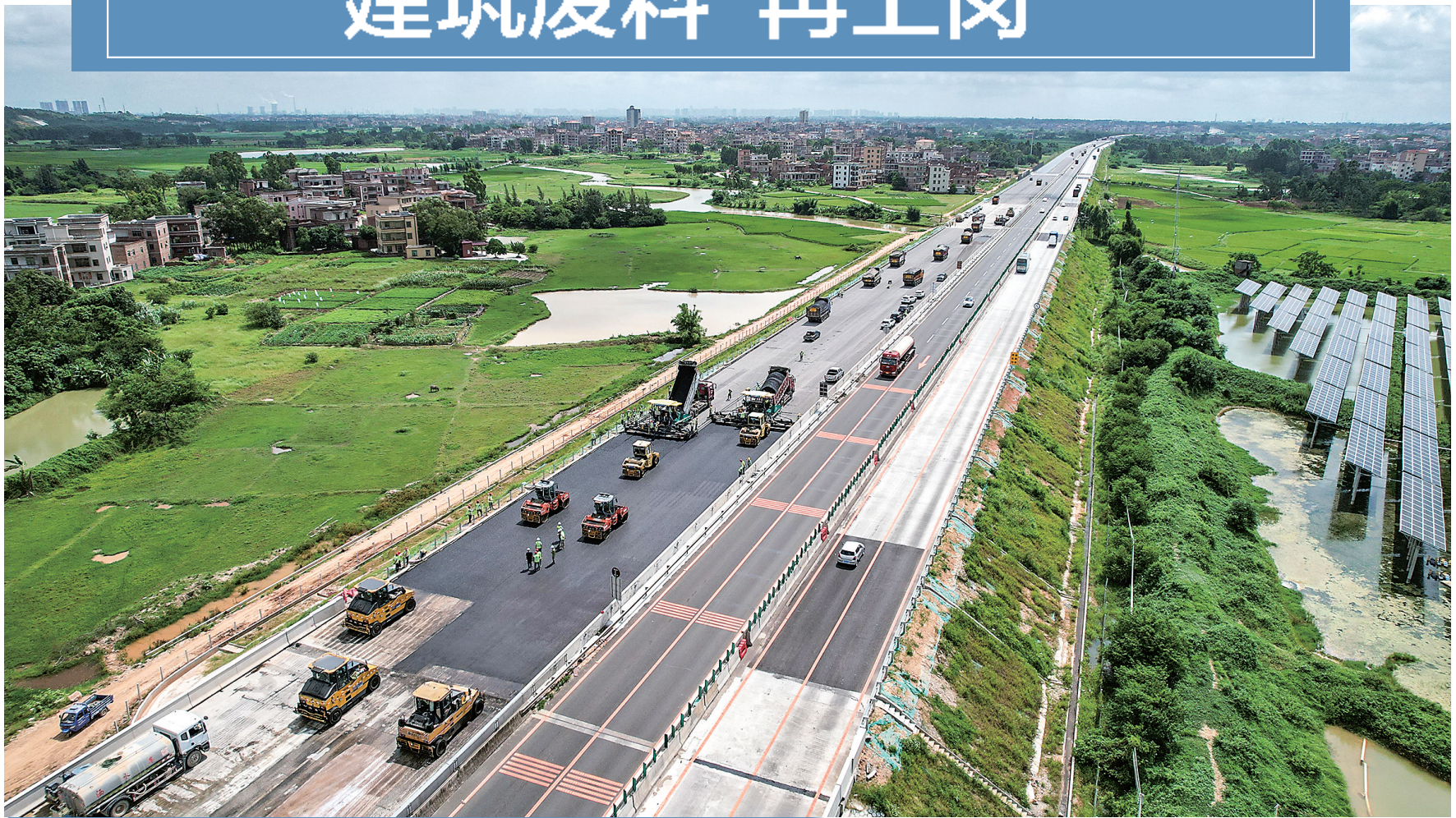
沥青路面热再生摊铺。通讯员沈高 张梦婷 摄
