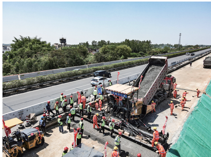
▲ 砣再生料用于垫层。 ▶ 沥青路面热再生摊铺。通讯员沈高 张梦婷 摄
