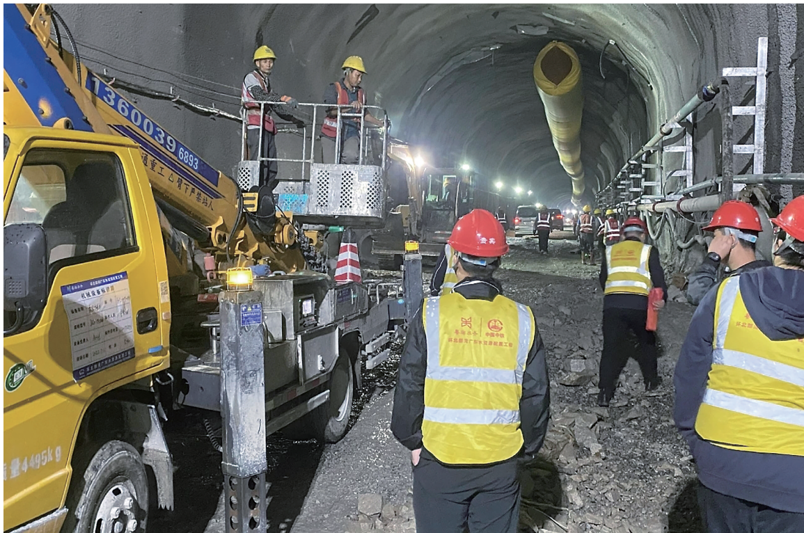
贵子支洞顺利掘进1000米。通讯员王庆珍 摄
