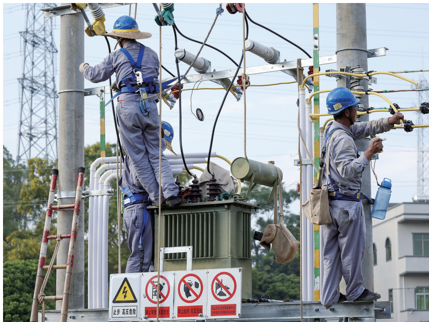
供电线路升级改造。通讯员 李峰 摄
