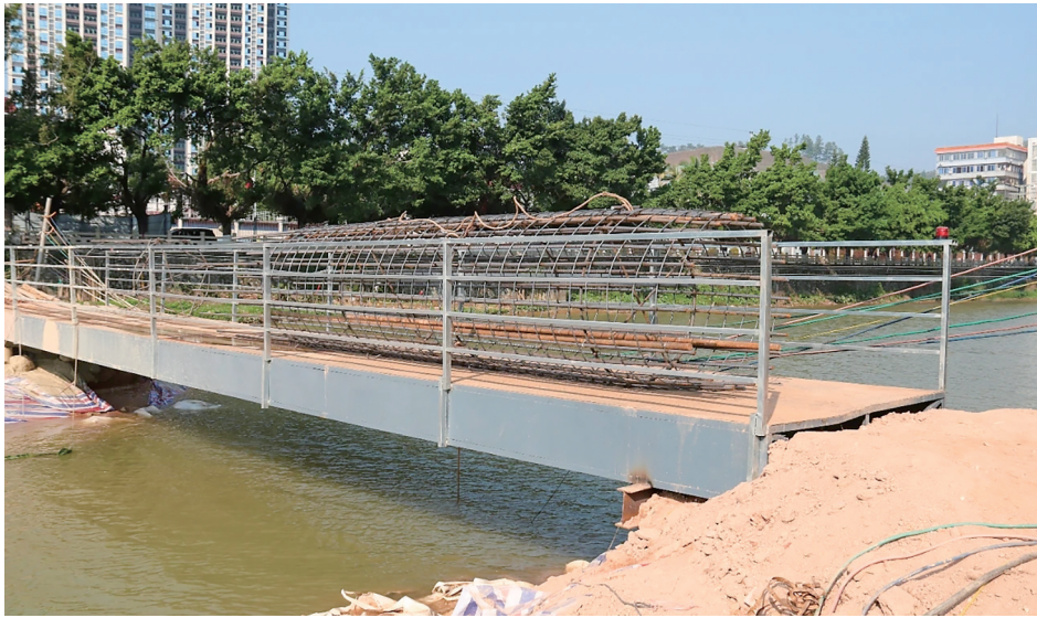
信宜城北桥加紧施工中。 茂名晚报通讯员 陆波 摄
