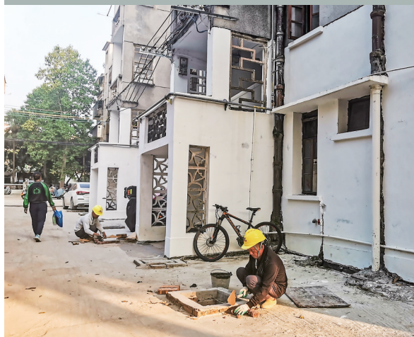
施工人员在红旗大院进行老旧建筑微改造工程。
