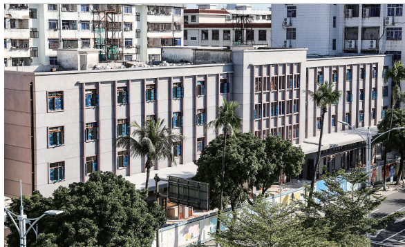
河西新华书店大楼外墙微改造已经基本完工。
