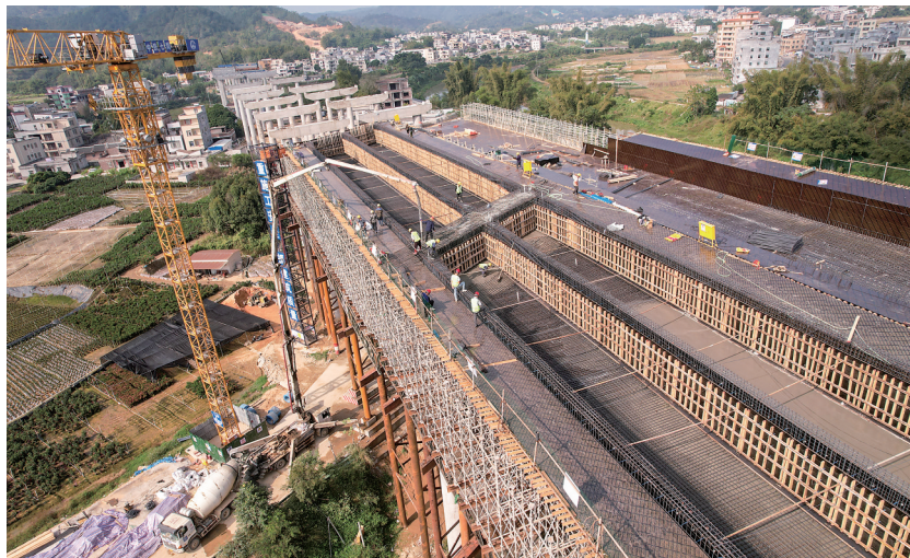
施工现场。通讯员唐富冉 陈治 摄
