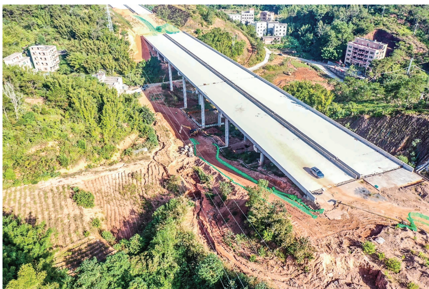
水系综合治项目正在施工中。茂名晚报通讯员程鸿 摄
