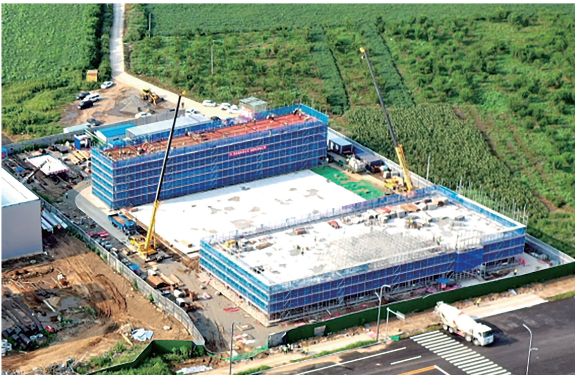
在沈阳市铁西区拍摄的德国贺利氏特种光源项目建设现场(2023年8月28日摄,无人机照片)。
