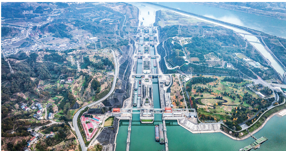
12月1日,船舶有序通过三峡双线五级船闸(无人机照片)。新华社记者伍志尊摄
