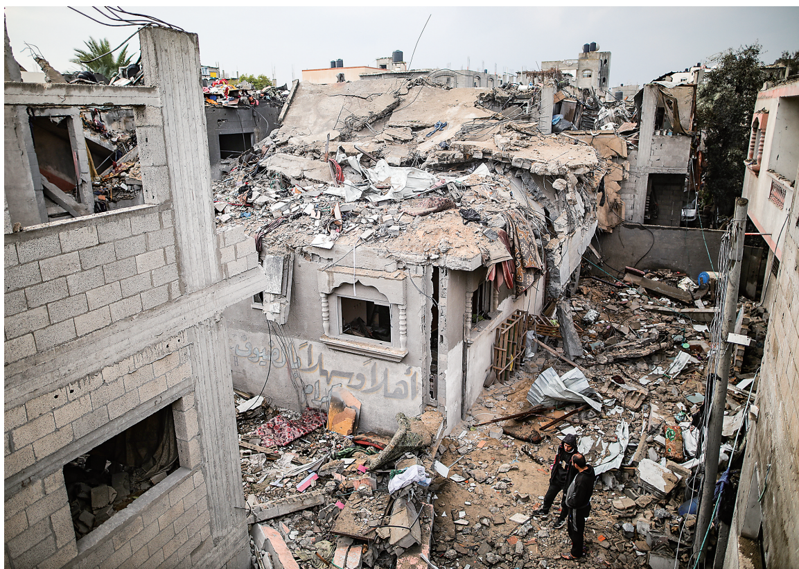
这是12月25日在加沙地带中部迈加齐难民营拍摄的以军空袭后的受损情况。新华社发
