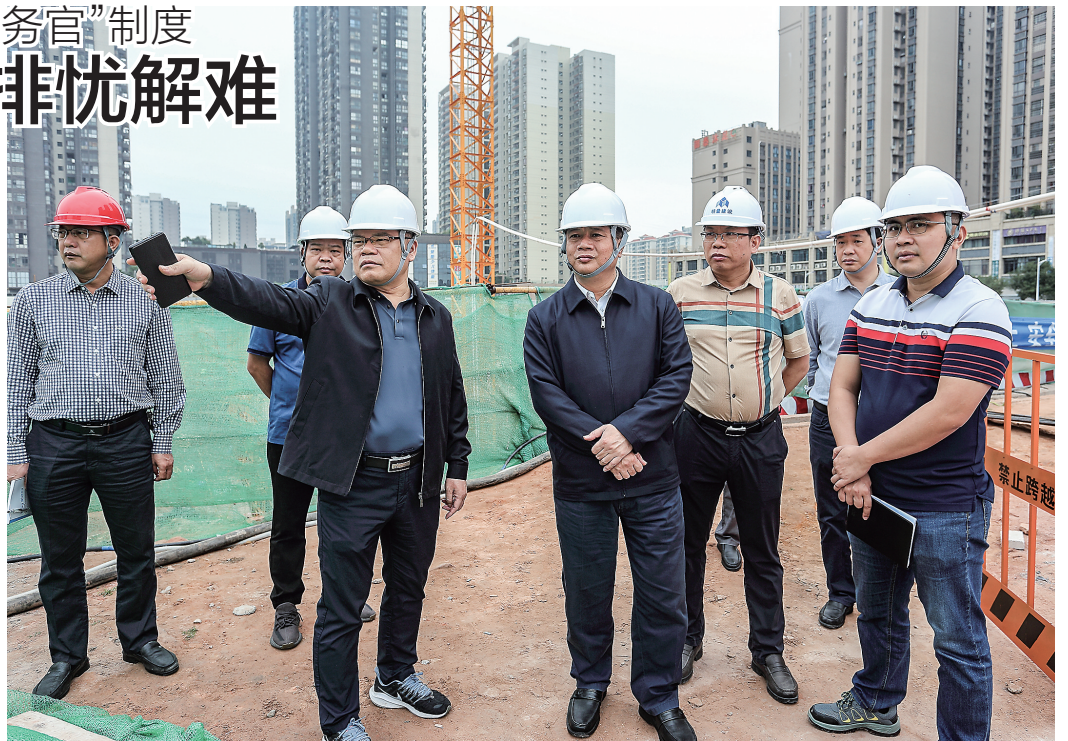
茂名市住建局“房地产企业服务官”深入房地产在建项目,了解项目生产情况。
