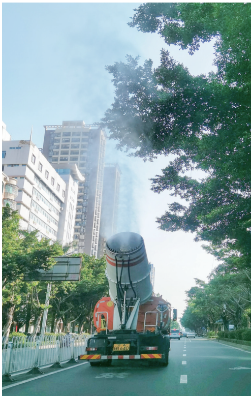
城市喷雾降尘作业。 茂名日报社全媒体记者 黄信涛 摄
