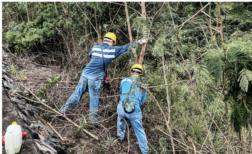
突击队员修剪树木确保春运供电安全。
