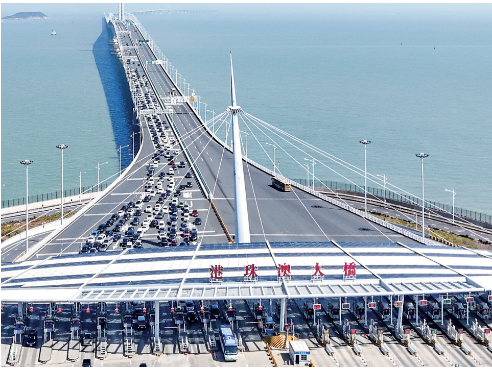
2月12日拍摄的港珠澳大桥桥头(无人机照片)。新华社发(王相国摄)
