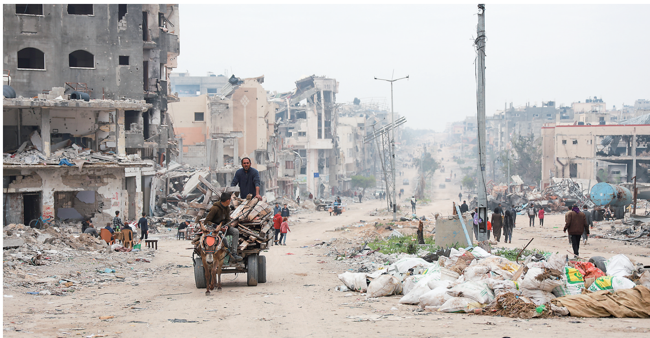
2月26日,人们路过加沙城的建筑废墟。新华社发(马利克·阿塔拉摄)
