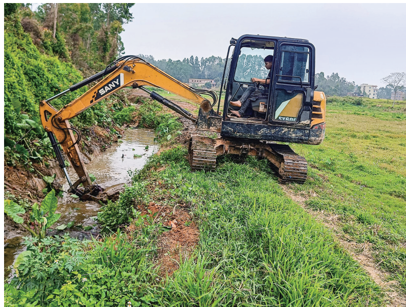
疏通清淤沟渠。茂名日报全媒体记者黎雄摄
