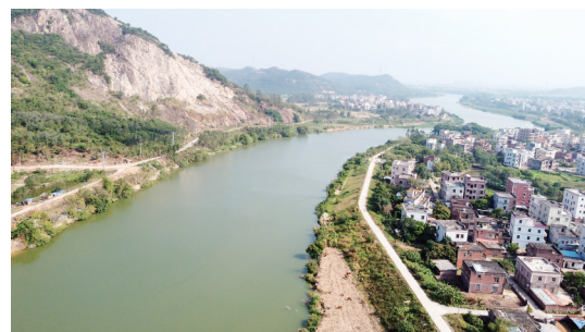
大王湾大桥施工河段。 茂名日报社全媒体记者黎雄 摄
