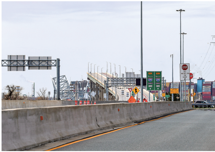
这是3月26日在美国马里兰州巴尔的摩拍摄的坍塌的大桥。新华社记者胡友松 摄
