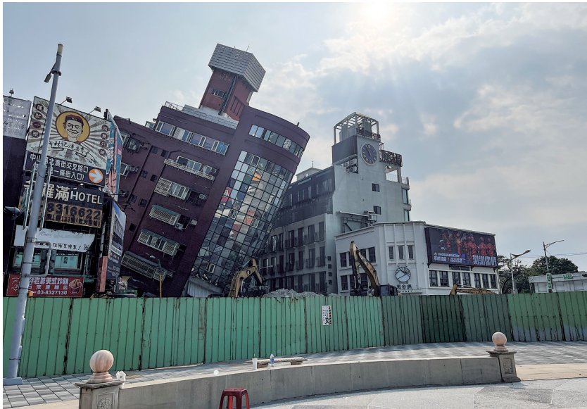
这是4月4日在花莲县花莲市区拍摄的倾斜的天王星大楼。新华社记者 赵博 摄
