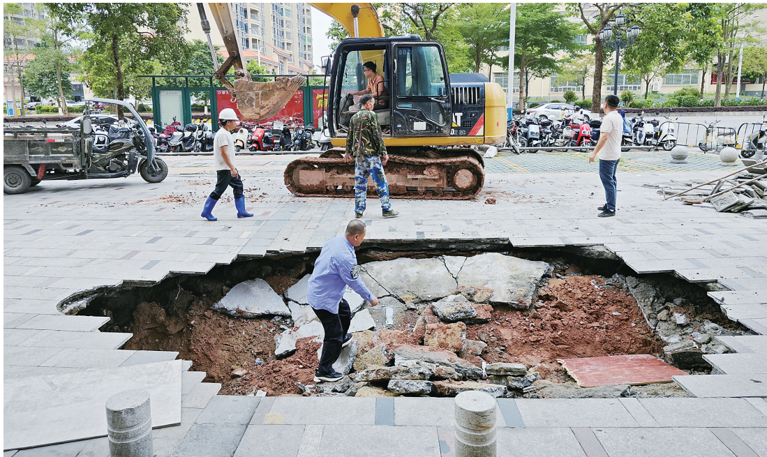
塌陷现场。记者张海锋 摄
