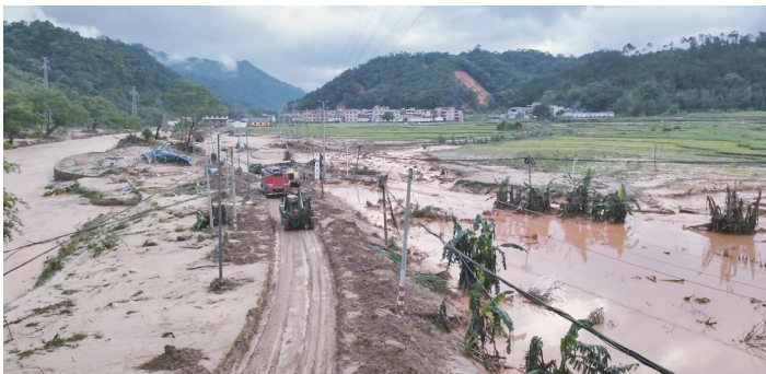
4月22日凌晨,南方电网(广东)综合应急基地应急特勤队进入韶关市武江区江湾镇,协助恢复通讯及抢修复电。(受访者供图)
