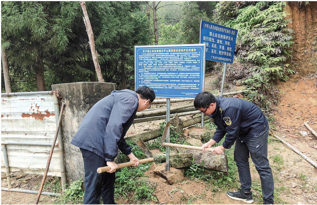
工作人员在林区重点路口安装安全防范教育警示牌。通讯员陈富强 摄
