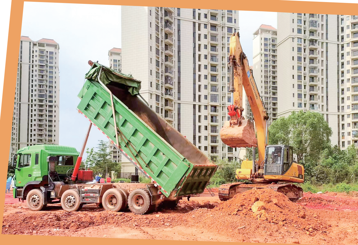
施工现场。茂名晚报通讯员覃庆满摄
