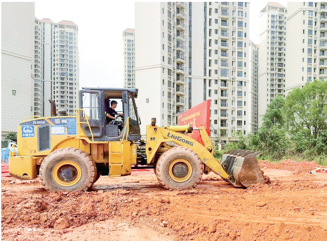
施工现场。通讯员覃庆满 摄
