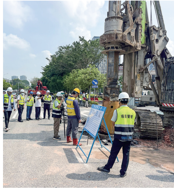
项目施工现场。
