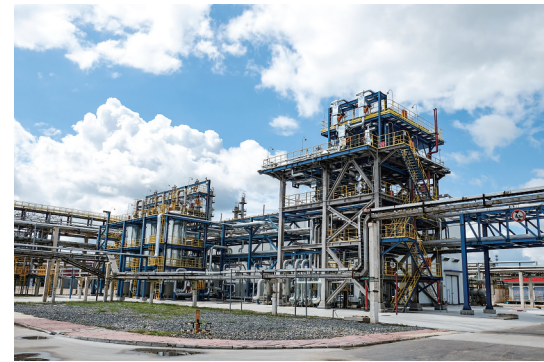
图为2023年9月1日拍摄的大庆石化公司40万吨/年二氧化碳回收装置。新华社记者魏海 摄
