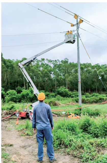
5月22日,电力施工人员正在现场进行架线作业。(李巨辉 摄)
