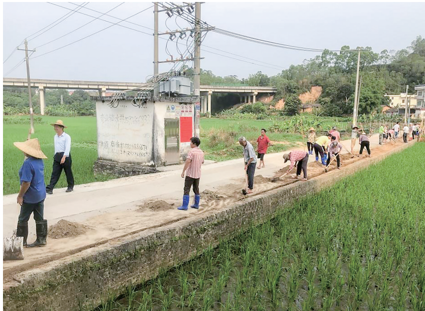
道路建设现场。通讯员曾霞 摄
