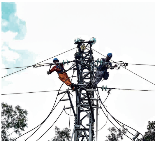
5月27日,在江湖镇连介村,供电施工人员正在安装线路绝缘子。 颜诗华 摄
