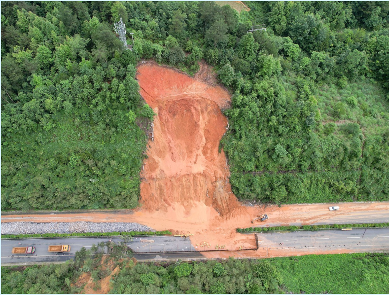
6月18日,在贵州省遵义市播州区三合镇一处山体滑坡现场,工作人员驾驶机械设备清理滑坡泥土(无人机照片)。 新华社发(张正举摄)
