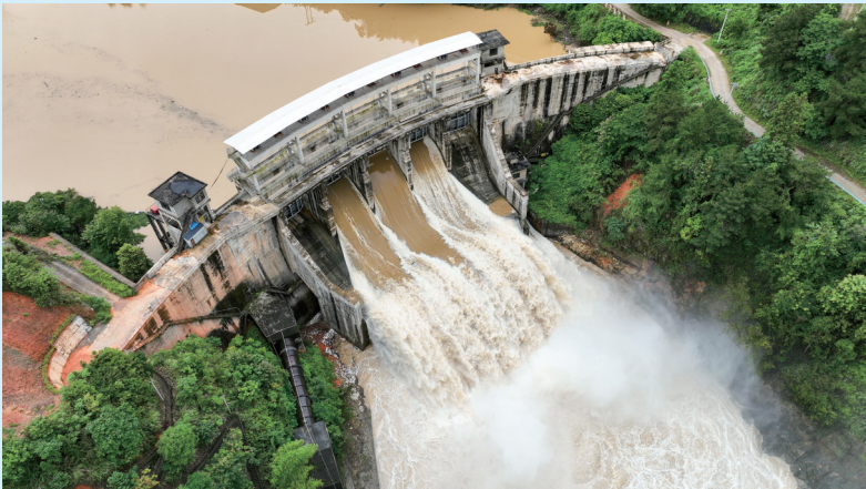
6月18日,位于贵州省黔东南苗族侗族自治州锦屏县境内的八河水电站开闸泄洪(无人机照片)。 新华社发(杨晓海摄)
