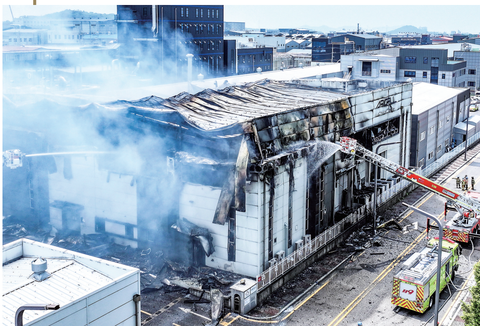
6月24日,消防员在韩国京畿道华城市的电池工厂火灾现场灭火。 新华社/美联
