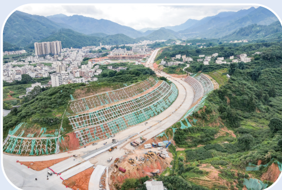
在建的钱排镇环城大道。
