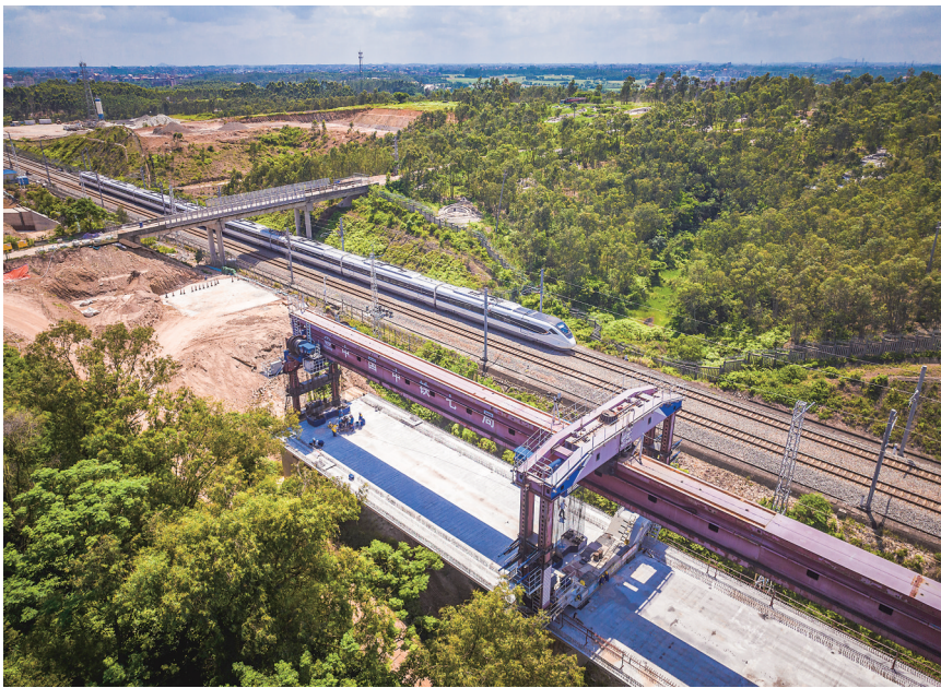
广湛铁路全线单体量最大梁场圆满完成箱梁架设任务。
