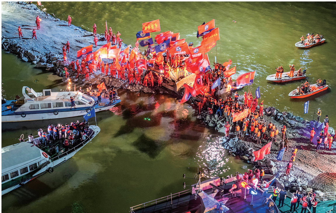
图为7月8日晚拍摄的团洲垸洞庭湖大堤决口封堵现场(无人机照片)。新华社记者 陈思汗 摄
