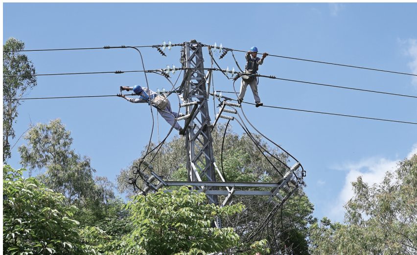
良光镇10千伏大桦线电力施工现场。通讯员颜诗华 摄
