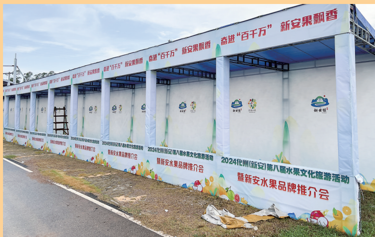
展销摊位已搭建完成。
