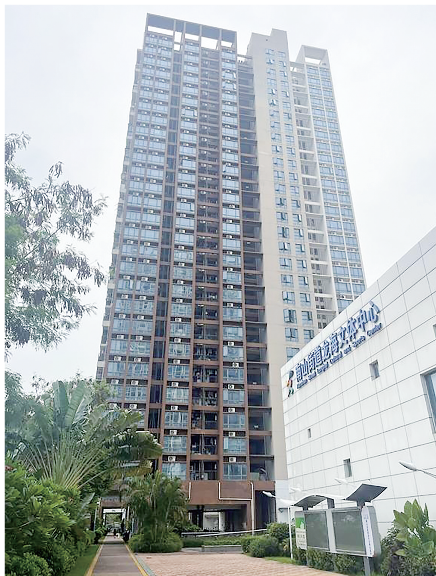
深圳地铁上盖保障房龙海家园。新华社记者赵瑞希摄
