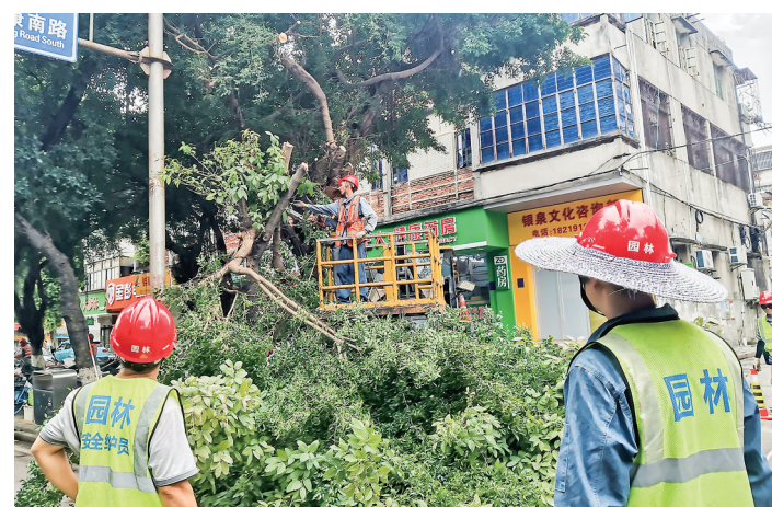
昨天,在市区红旗南路,园林工人利用吊臂车抓紧修剪马路两旁的高大路树,防止粗大枯枝坠落时发生伤人意外,做好台风雨季的预防措施。 茂名日报社全媒体记者 岑稳 摄
