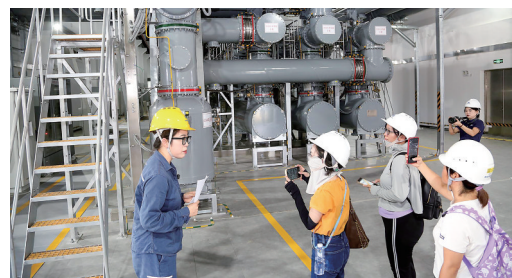
了解数字化、智能化变电站建设情况。
