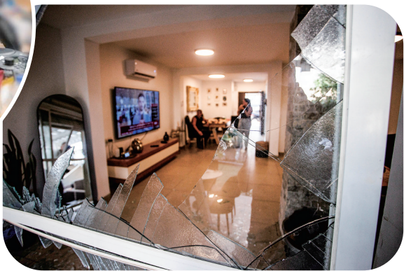
▲这是8月25日在以色列北部城市阿卡拍摄的遭袭建筑。 新华社/基尼图片社
