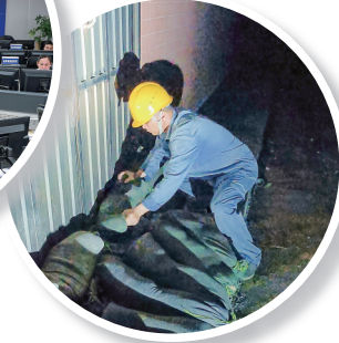
▶ 茂名茂港供电局沙院供电所对港城开关站、码头开关站、恒和配电站等重要供电设备设施场所进行门窗加固以及沙袋封堵工作。易华富 摄
